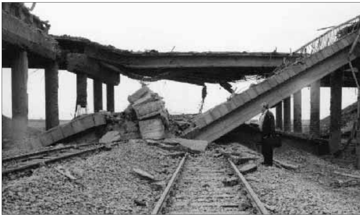
I resti di un ponte abbattuto dalle bombe Nato che hanno interrotto la linea ferroviaria
