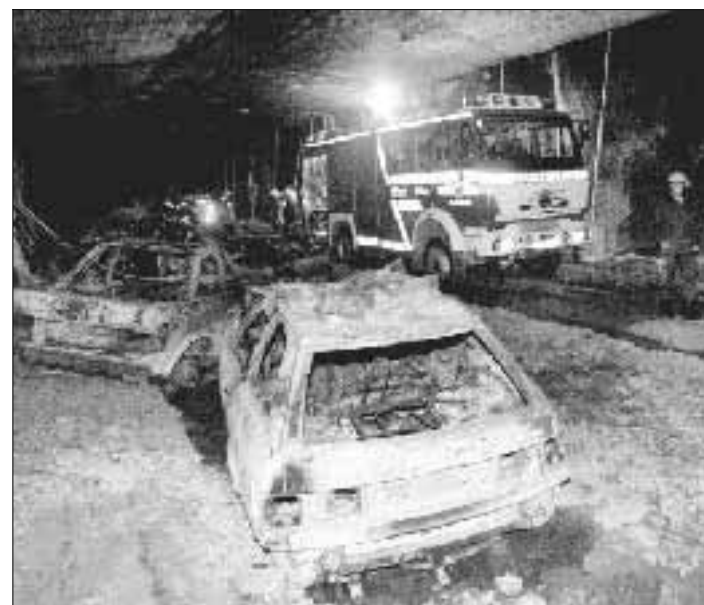
Auto distrutte nell'incendio del tunnel dei Tauri Heinz-Peter Bader/Reuters
