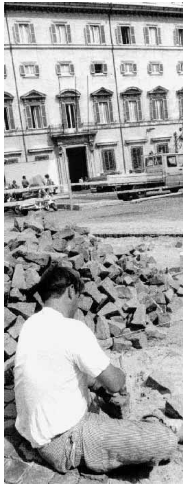
Lavori di rifacimento di piazza Colonna
