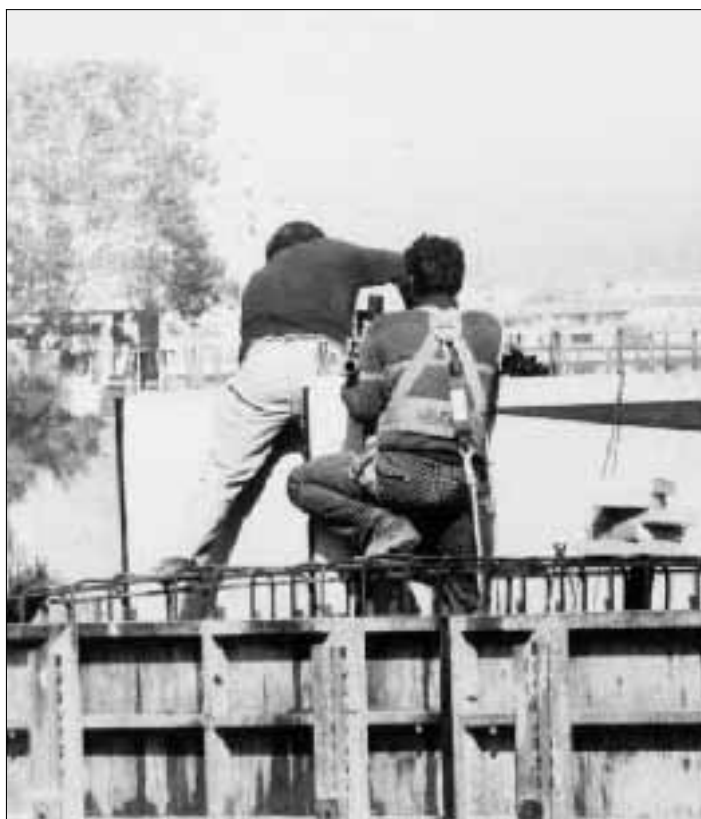
Operai edili al lavoro
