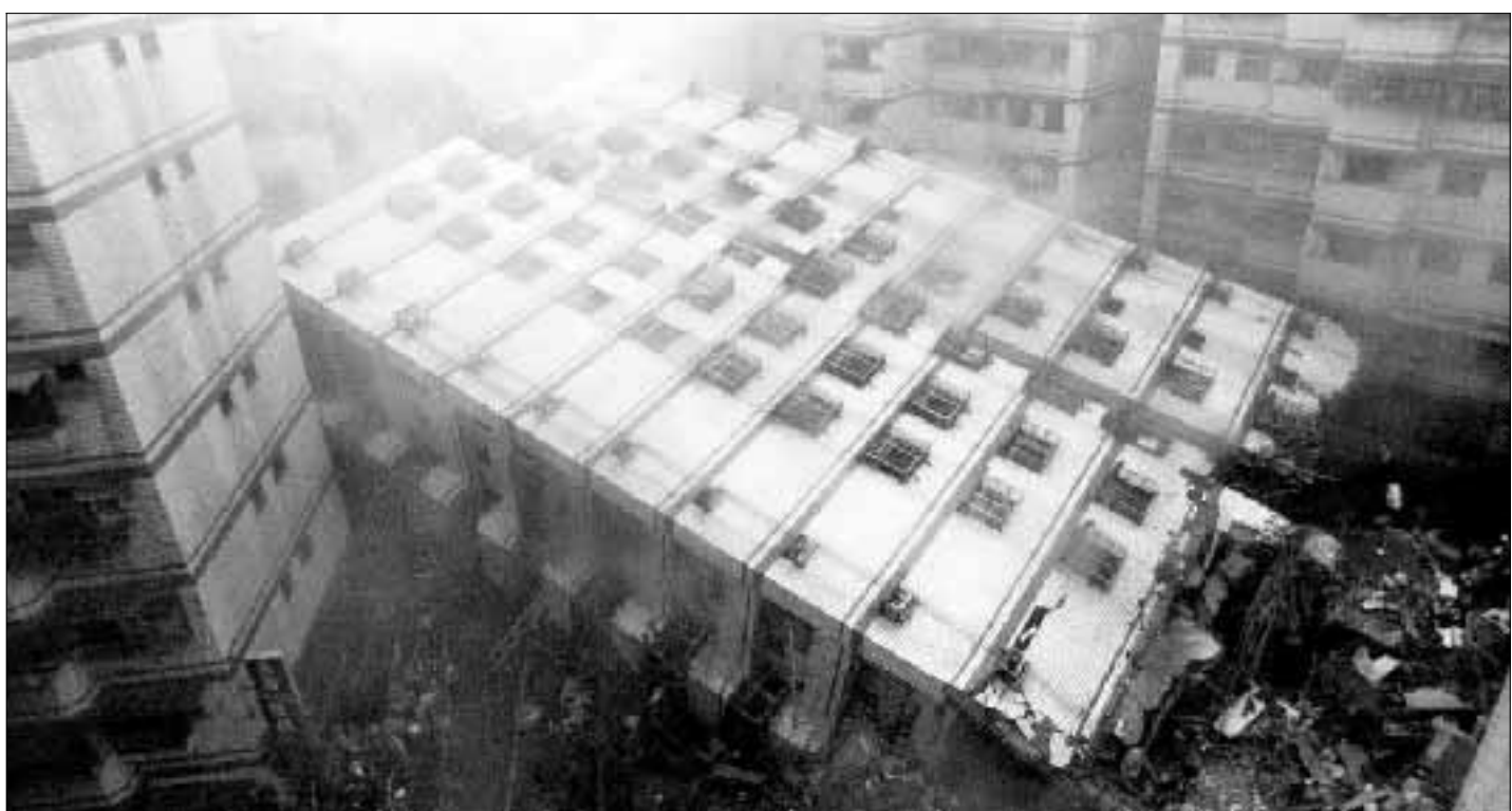
Un palazzo adagiato su di un fianco, a lato una statua rimasta al suo piedistallo dopo la forte scossa di terremoto
