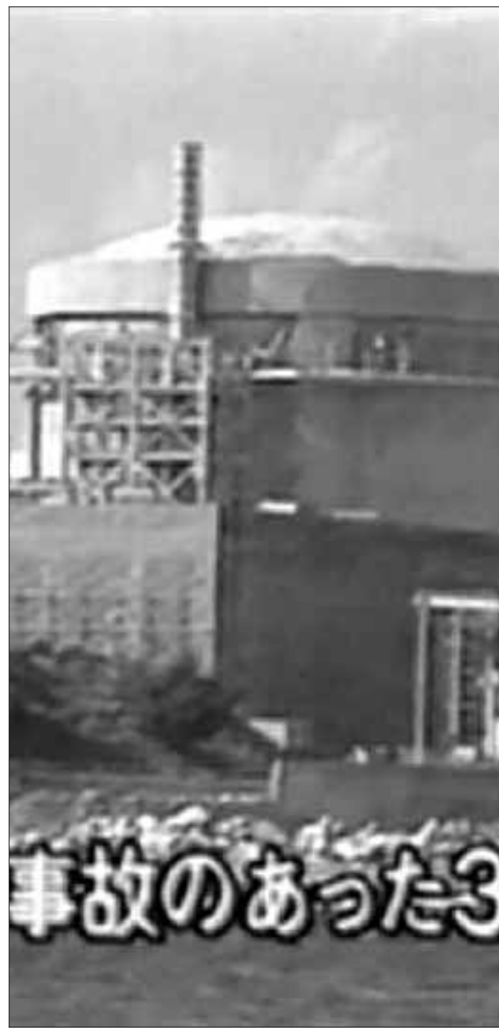
Una immagine televisiva della centrale coreana
