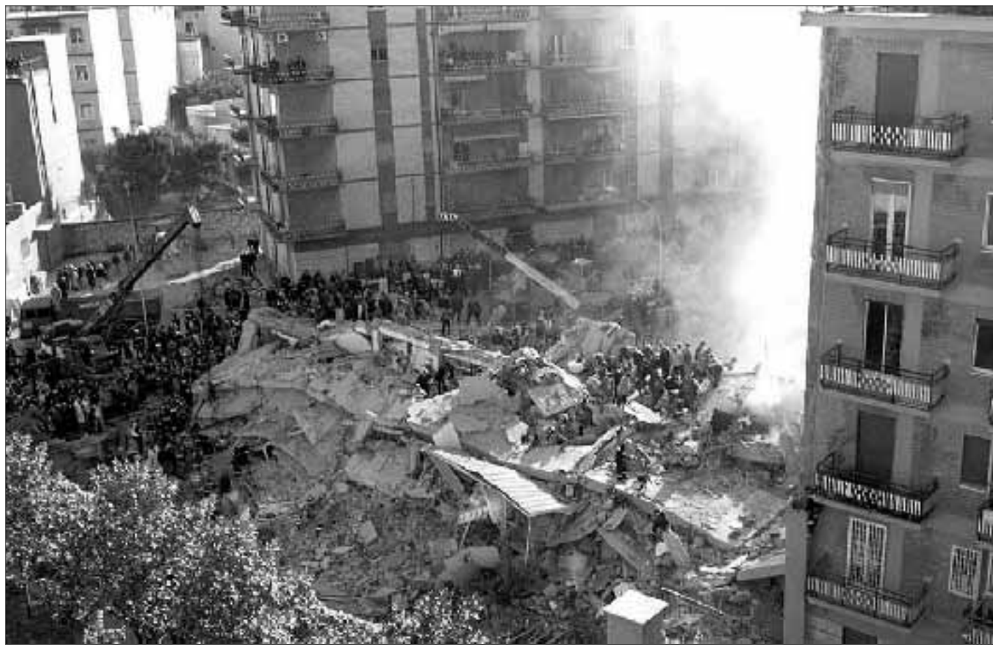
Vigili del fuoco, protezione civile e volontari al lavoro tra le macerie del palazzo
