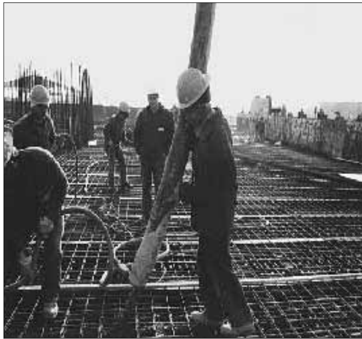
Un edile al lavoro in un cantiere
