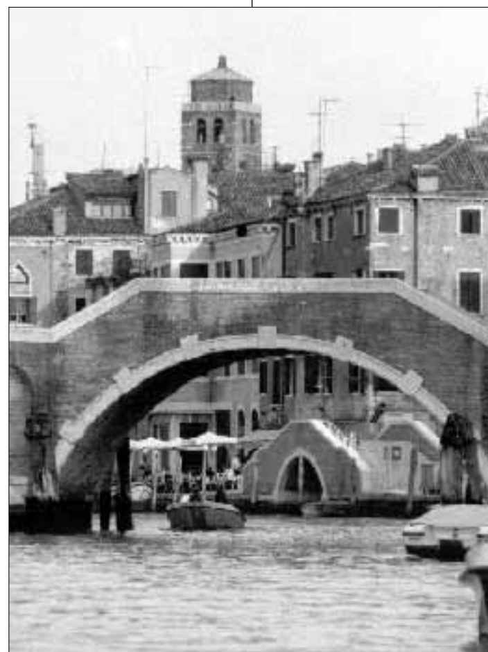
Il Ponte dei Tre archi ristrutturato dalla giunta Cacciari e in alto, nuove costruzioni all'Isola della Giudecca volute dalla giunta lagunare Gabriella Mercadini
