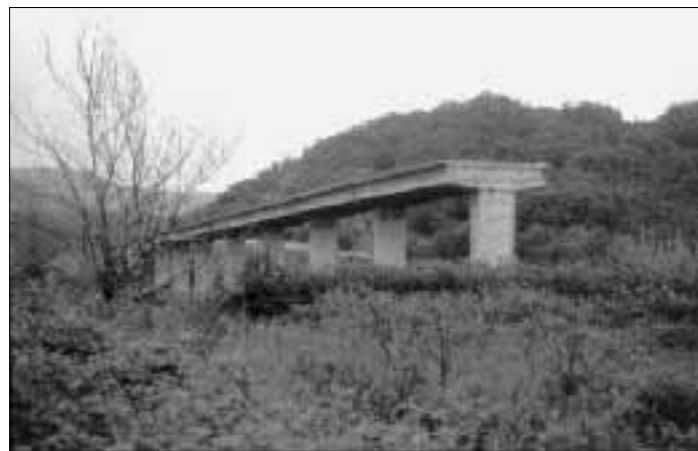
Viadotto iniziato nel 1975 in Abruzzo e mai completato perché costruito su terreno franabile
