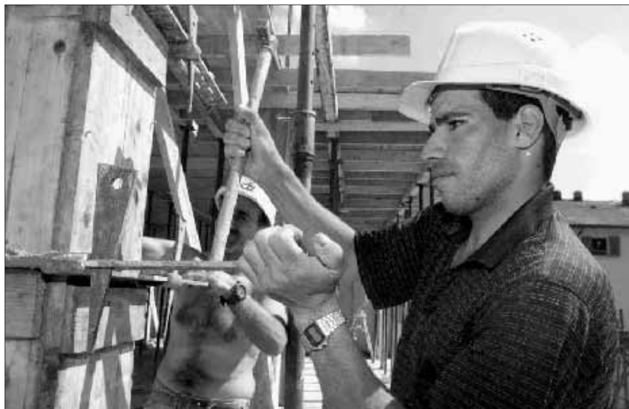
Un operaio egiziano al lavoro in un cantiere nel centro di Milano
