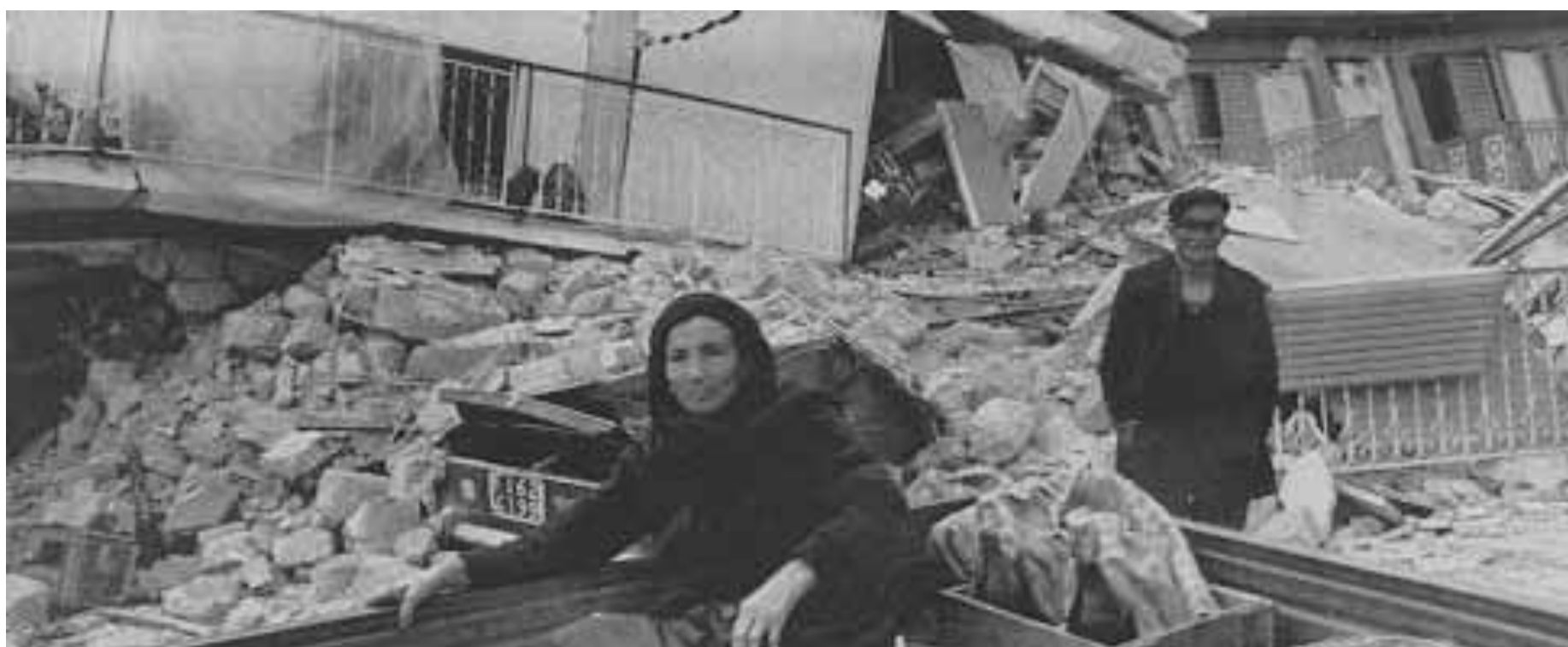
Lioni in provincia di Avellino uno dei paesi distrutti dal terremoto del 1980
