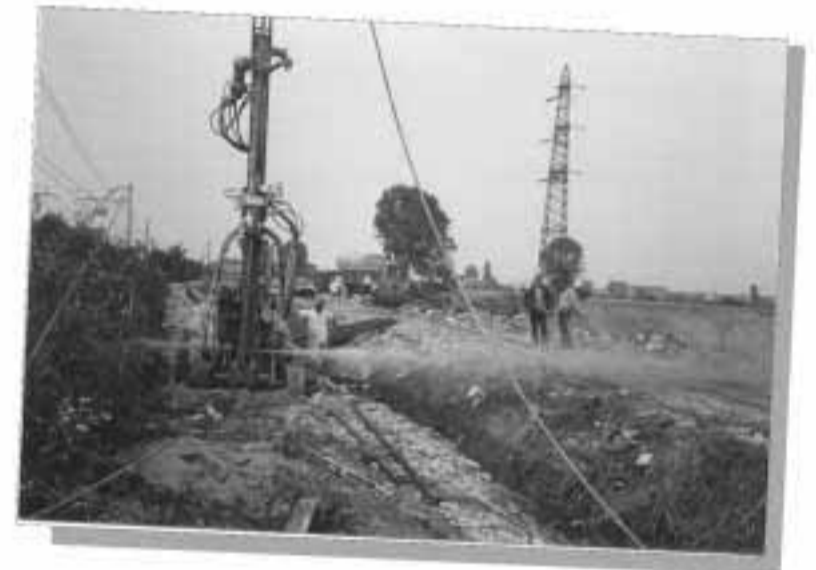
Consolidamento rilevati ferroviari mediante colonne di terreno consolidato. (Jet-grouting)
