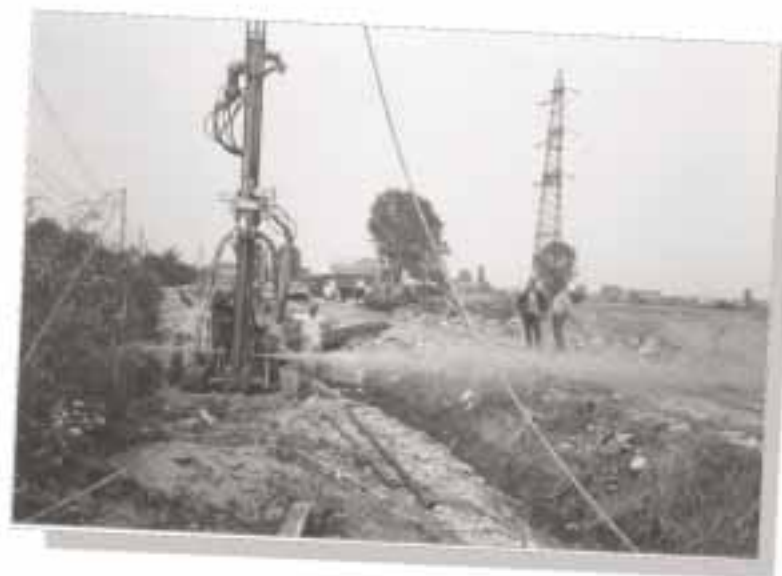
Consolidamento rilevati ferroviari mediante colonne di terreno consolidato. (Jet-grouting)
