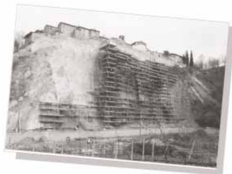
Consolidamento parete rocciosa a salvaguardia dell'abitato di Linaro (FO) (Ancoraggi - tiranti e spritz-beton)
