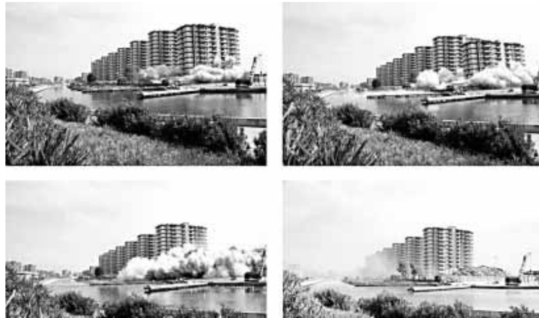
La sequenza dell'abbattimento delle torri edificate abusivamente a Castelvoturno
