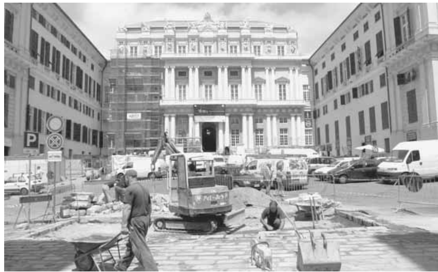
Fervono i lavori al Palazzo Ducale di Genova, sede del vertice G8 dei capi di Stato e di governo; sotto, don Vitaliano
