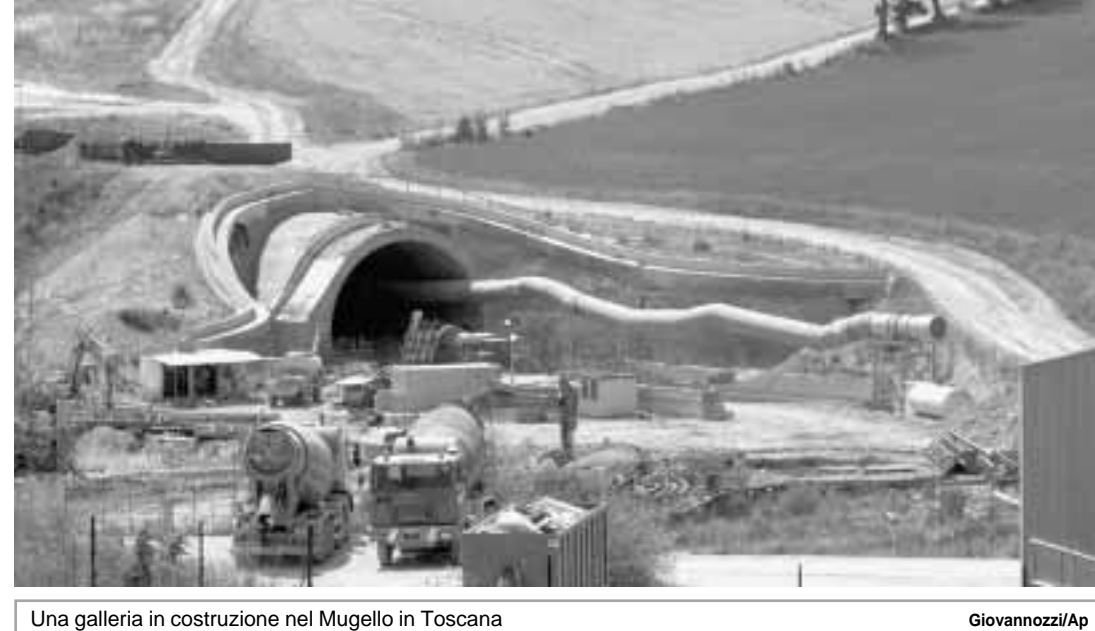
Una galleria in costruzione nel Mugello in Toscana
