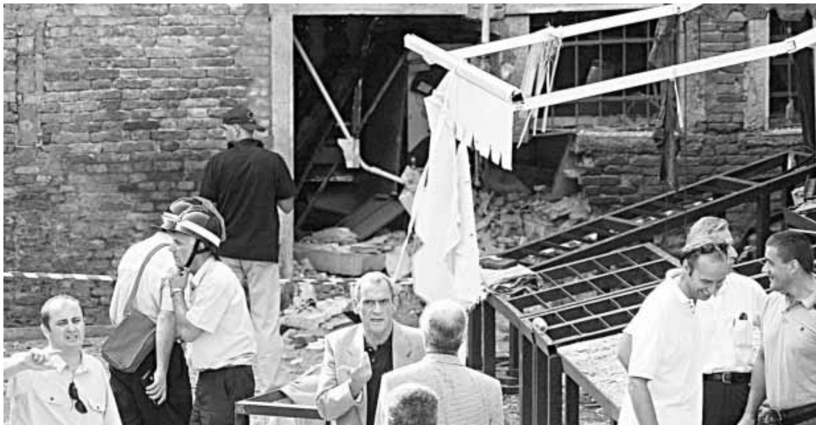
Il locale della caldaia del Tribunale di Venezia dove è avvenuta la devastante esplosione. In basso Felice Casson Merola-Pattaro/Ansa
