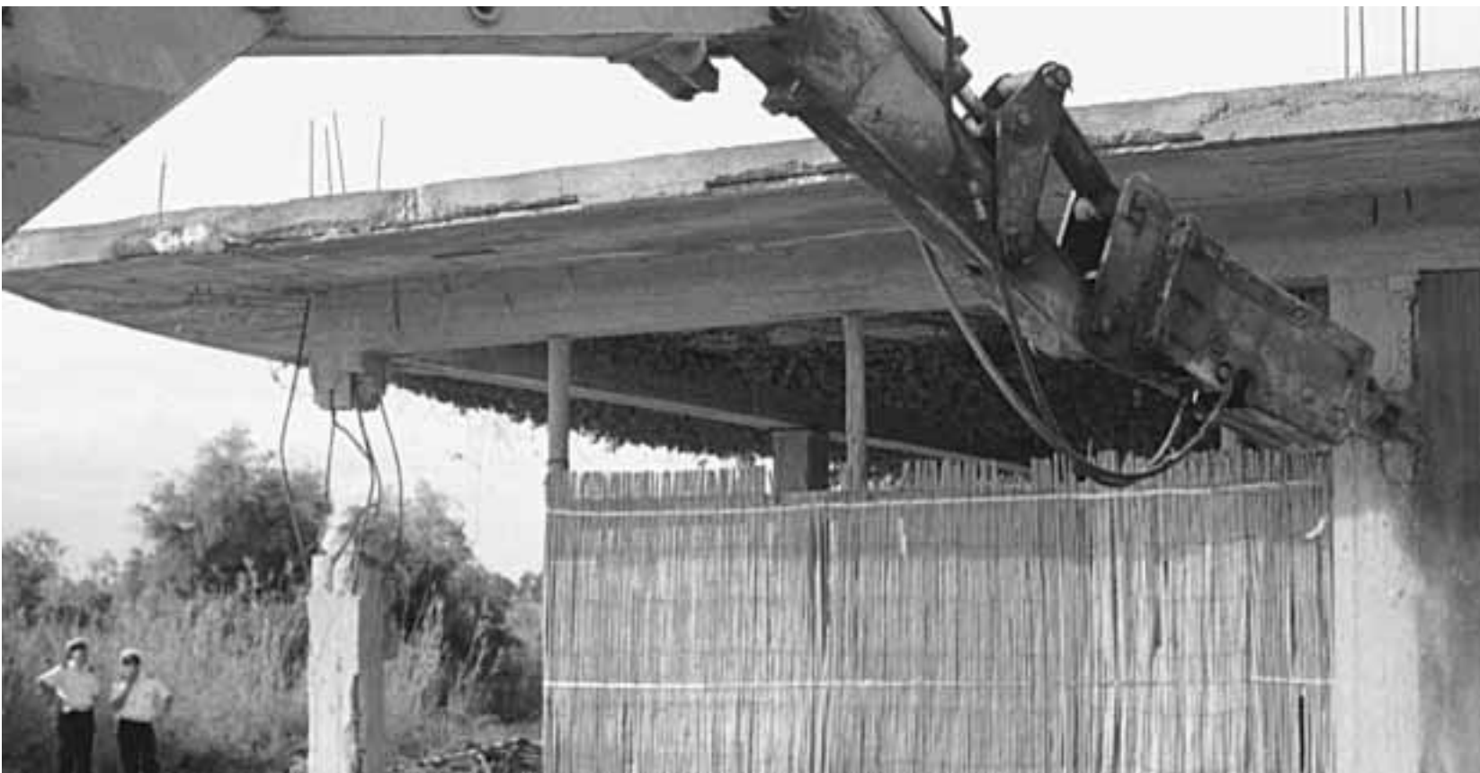
Una ruspa al lavoro per la demolizione di una casa abusiva
