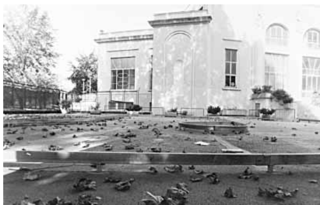
La palazzina liberty con un'area attrezzata per i bambini ora regno dell'immondizia e il cancello di ingresso della piscina che rimane sbarrato dieci mesi all'anno
