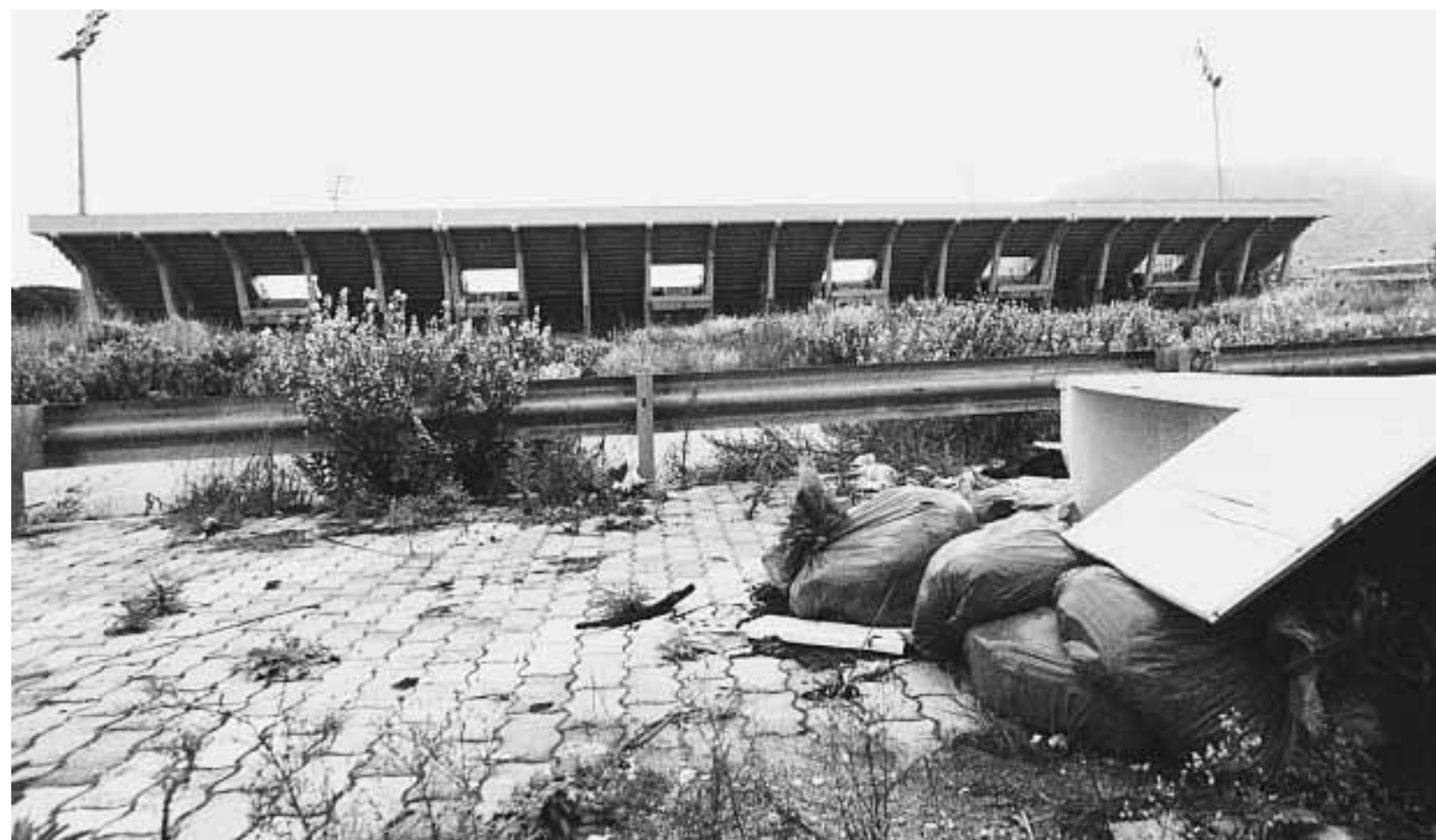
Lo stadio di Cercola "affollato" di erbacce e rifiuti. La pista dell'ex velodromo olimpico di Roma che sarà trasformato in un centro polivalente
