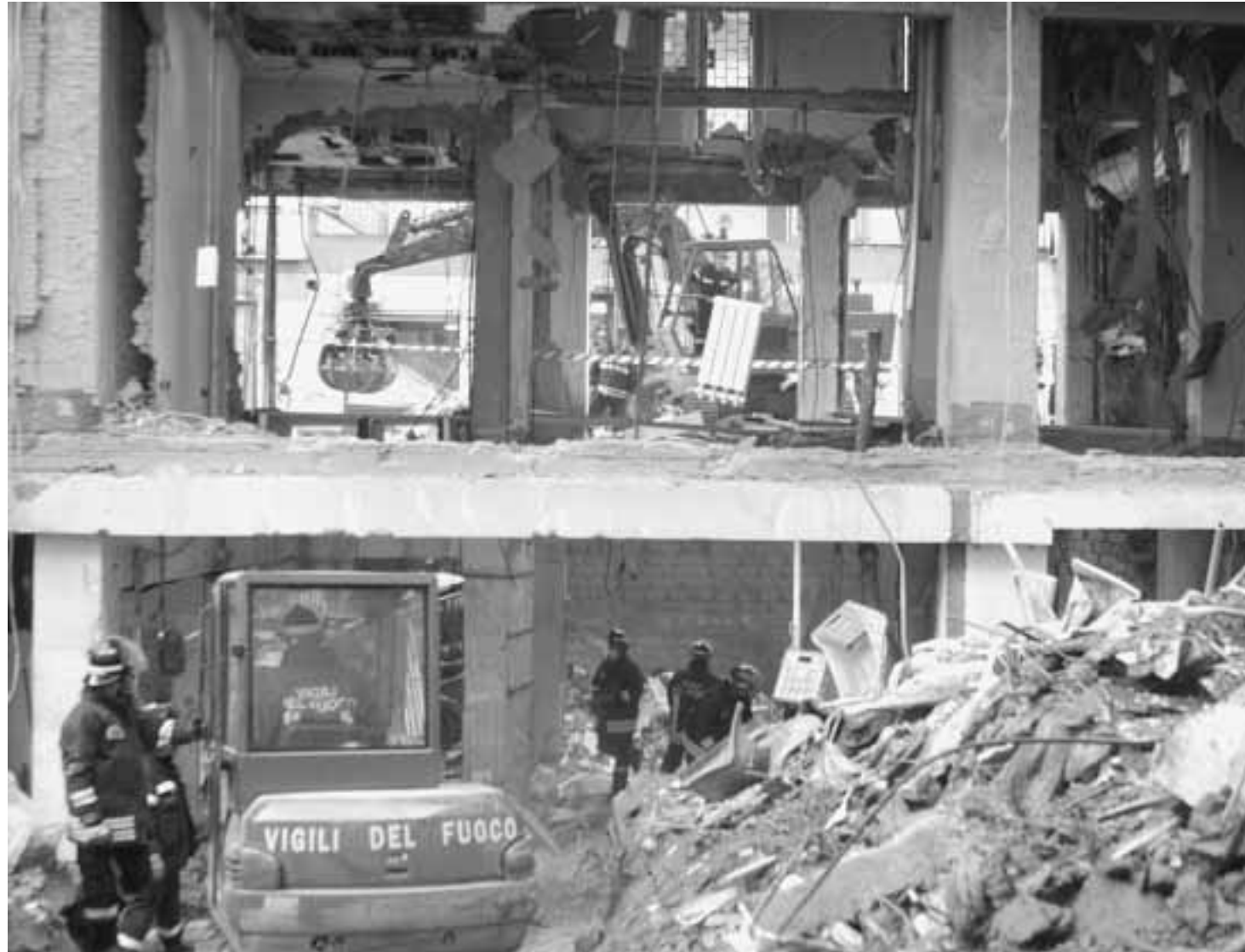
Il palazzo di via Ventotene sventrato dallo scoppio per una fuga di gas
