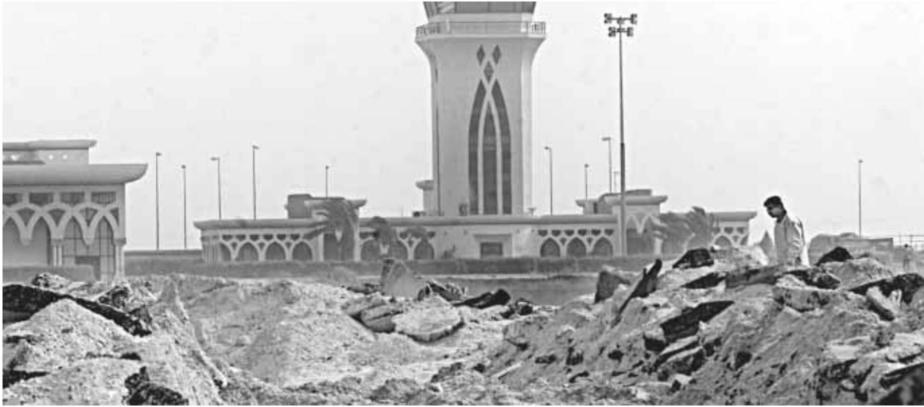
Tecnici palestinesi controllano la pista danneggiata dal bombardamento israeliano dell'aeroporto di Gaza
