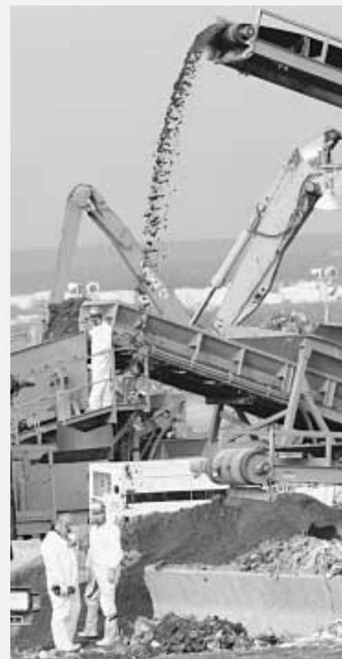
A sinistra, a lato e in alto a destra tre momenti del recupero di ciò che resta dopo l'11 settembre
