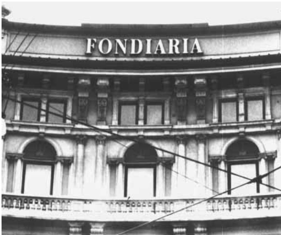
La sede della Fondiaria a Milano
