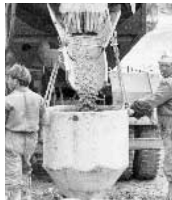
Un operaio in un cantiere edile
