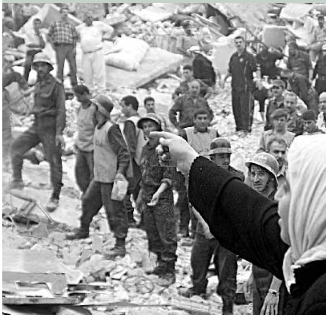
Una donna indica agli operai il luogo dove potrebbe essere il corpo del marito, disperso nel crollo di alcune case ad Aleppo, in Siria: già 24 sono i morti accertati.
