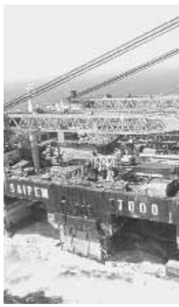
La nave posatubi della Saipem
