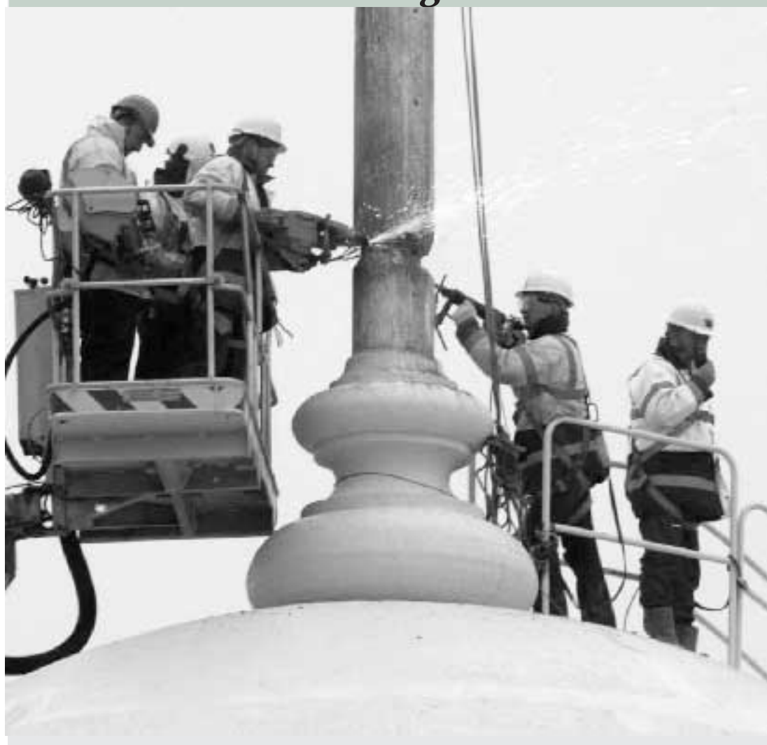
I lavori di demolizione allo stadio Wembley
