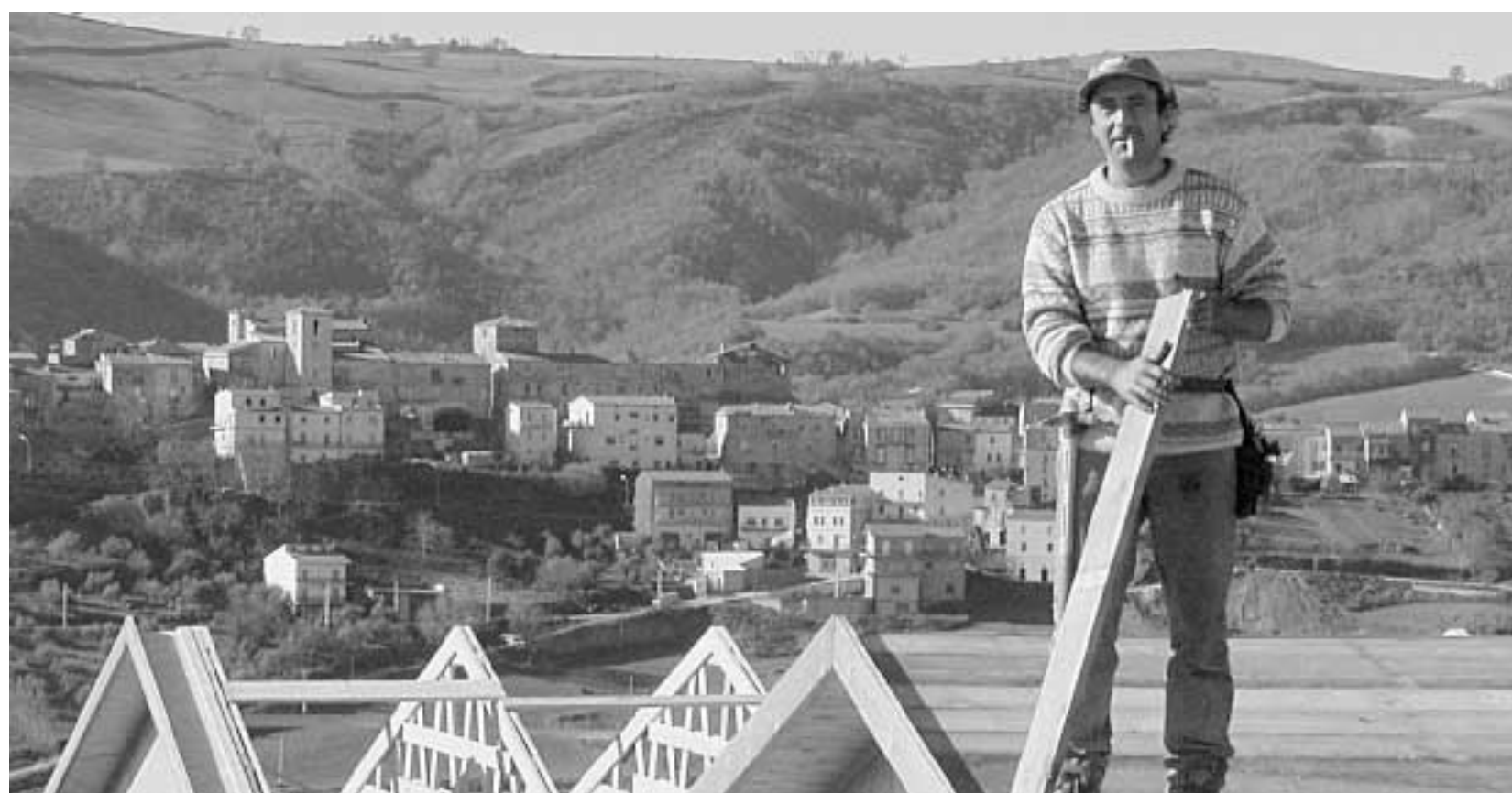
Un operaio lavora alla ricostruzione del paese di San Giuliano. Massimo Di Nonno/Mediamind
