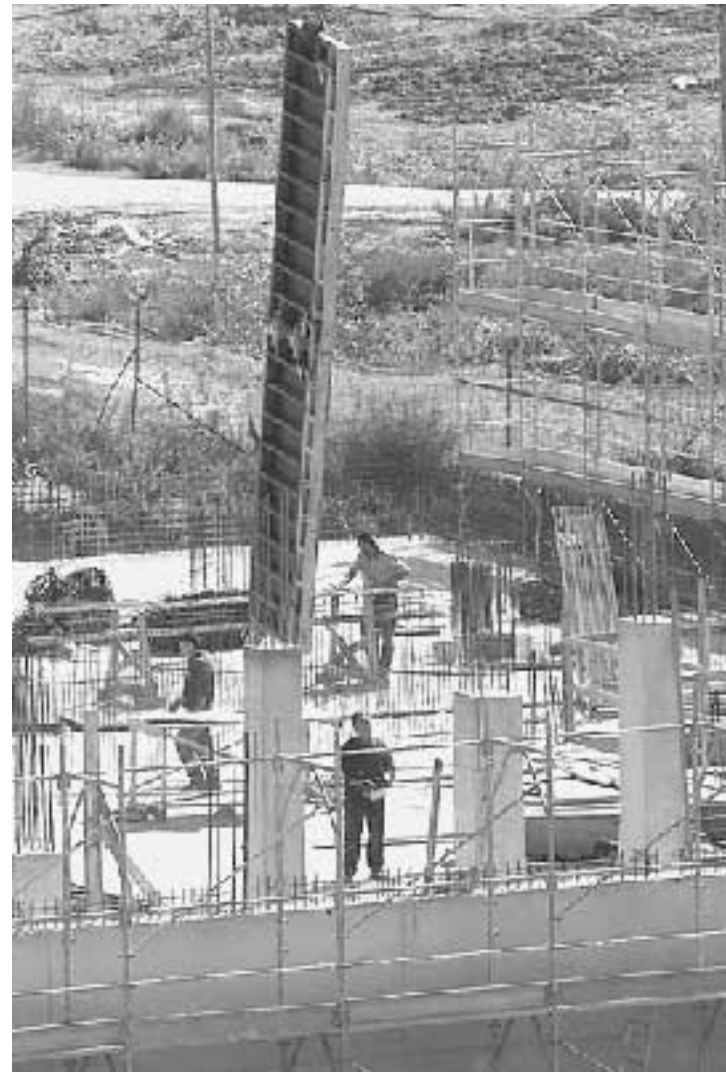
Un cantiere edile
