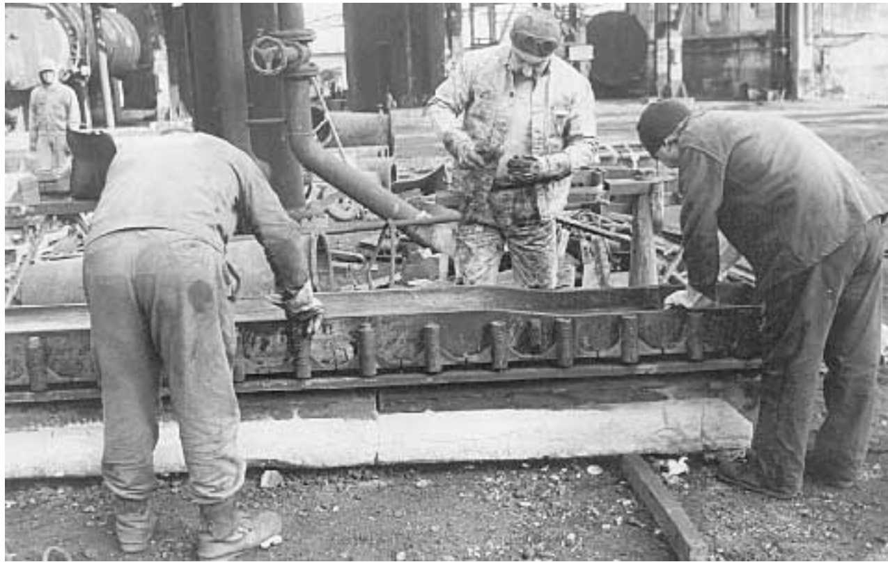
Operai al lavoro in una acciaieria
