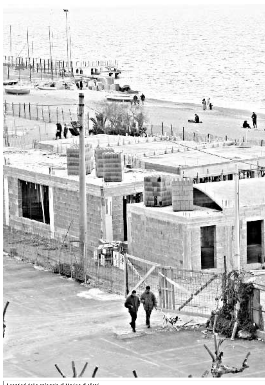
I cantieri della spiaggia di Marina di Vietri
