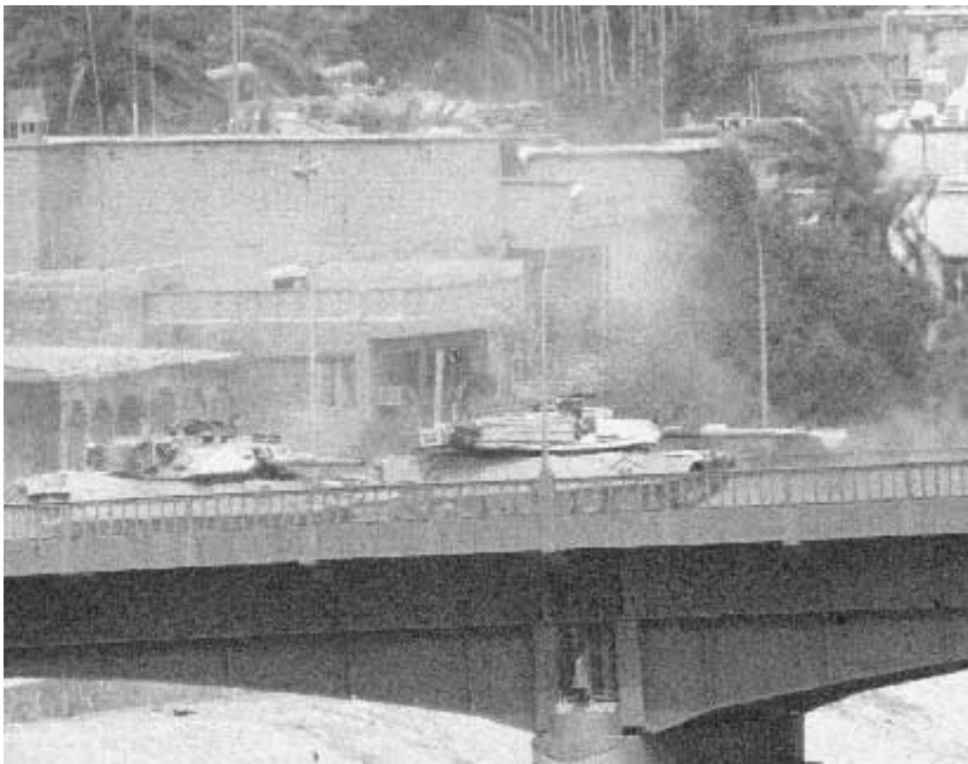
Due tanks americani mentre sparano dal ponte Al-Jumhuriya verso l'hotel Palestine, a destra i segni sulla facciata
