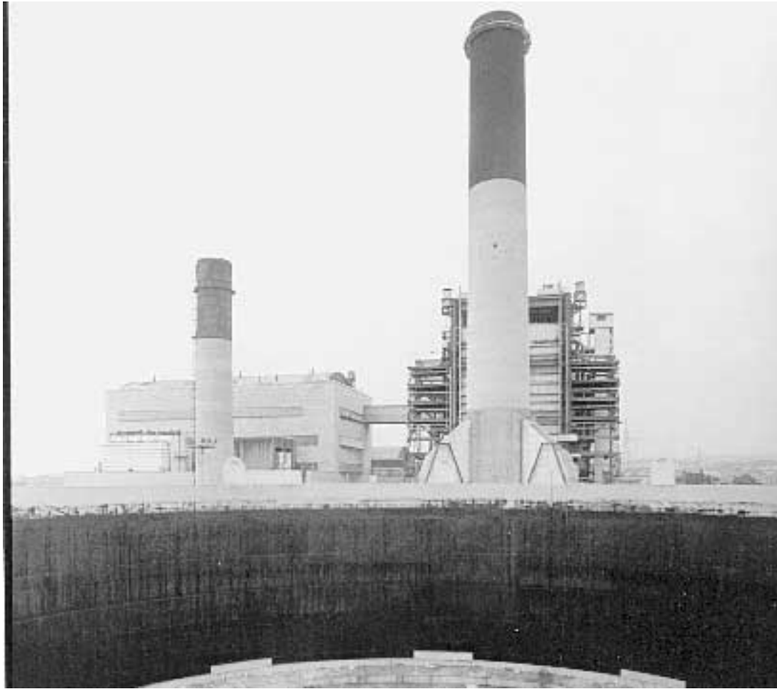
La centrale termoelettrica Enel di Civitavecchia
