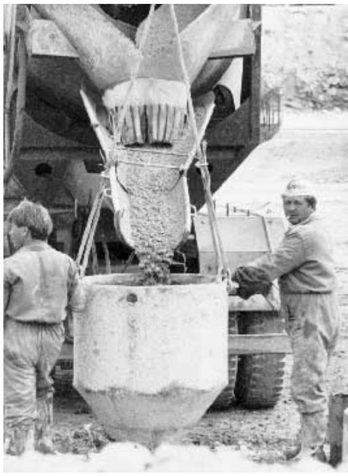
Operai in un cantiere
