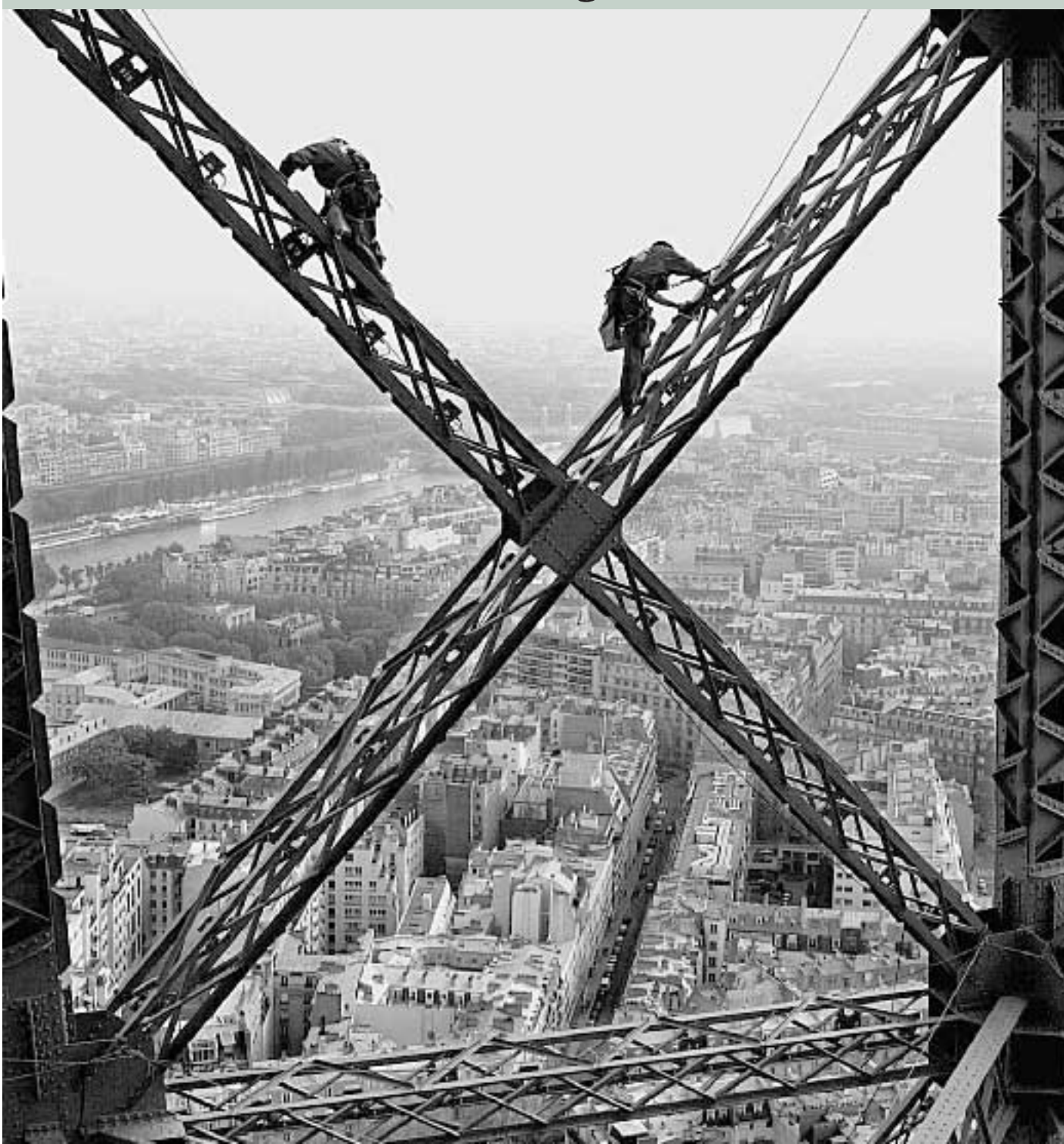
Operai al lavoro per l'installazione di nuove luci sulla Torre Eiffel: si tratta di ventimila lampadine intermittenti
