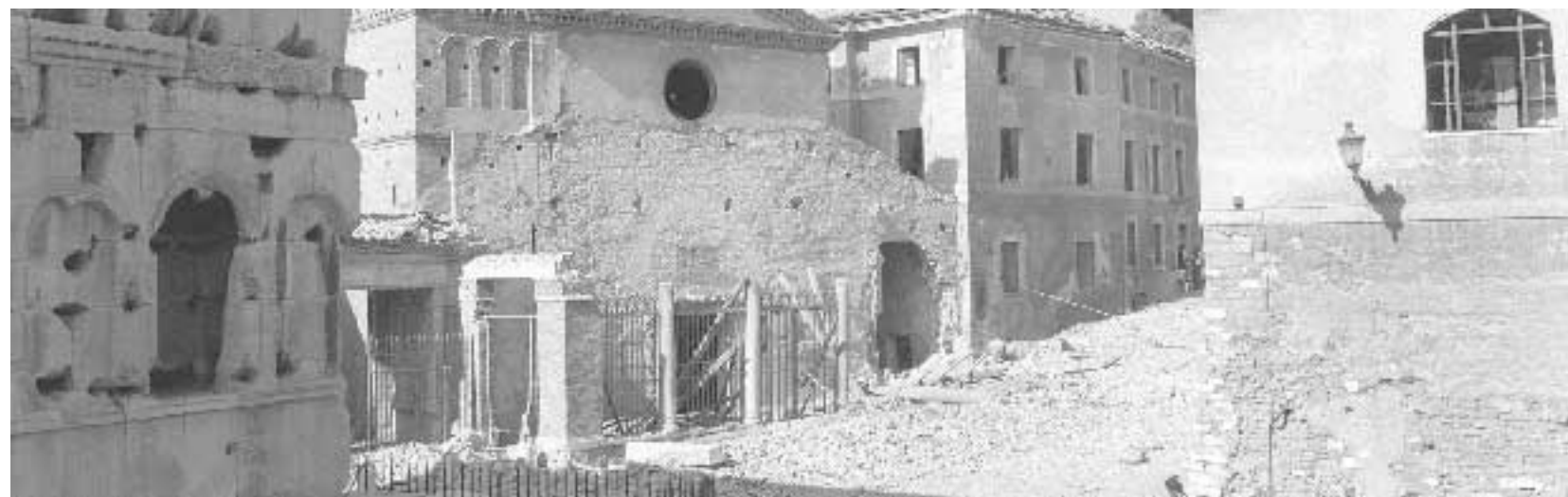
La chiesa di San Giorgio al Velabro a Roma dopo l'attentato compiuto poco dopo la mezzanotte tra il 27 e il 28 Luglio 1993
