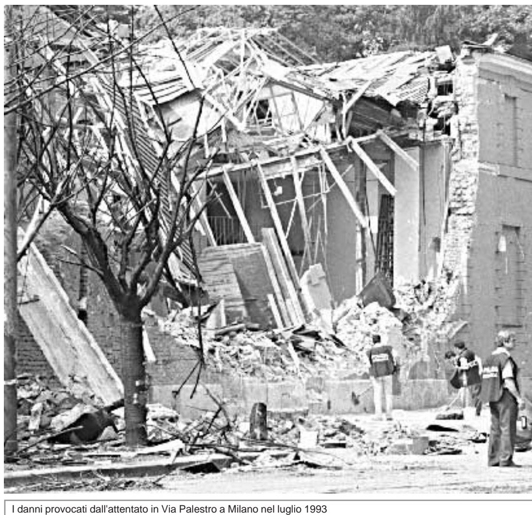
I danni provocati dall'attentato in Via Palestro a Milano nel luglio 1993
