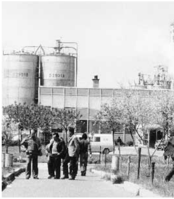
Una immagine dell'impianto Montefibre di Ottana
