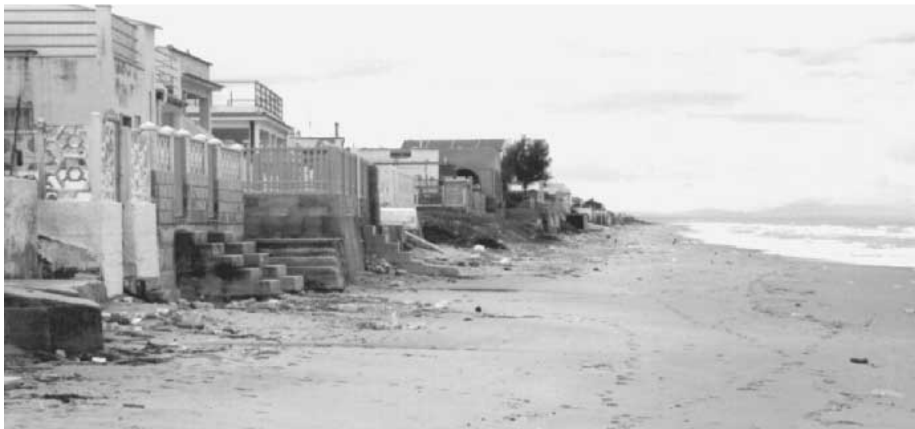
L'istmo di Lesina con le villette costruite abusivamente. Sopra: la cartina con il perimetro del parco del Gargano. Zona 1: vincoli assoluti ambientali e paesaggistici; zona 2: area protetta
