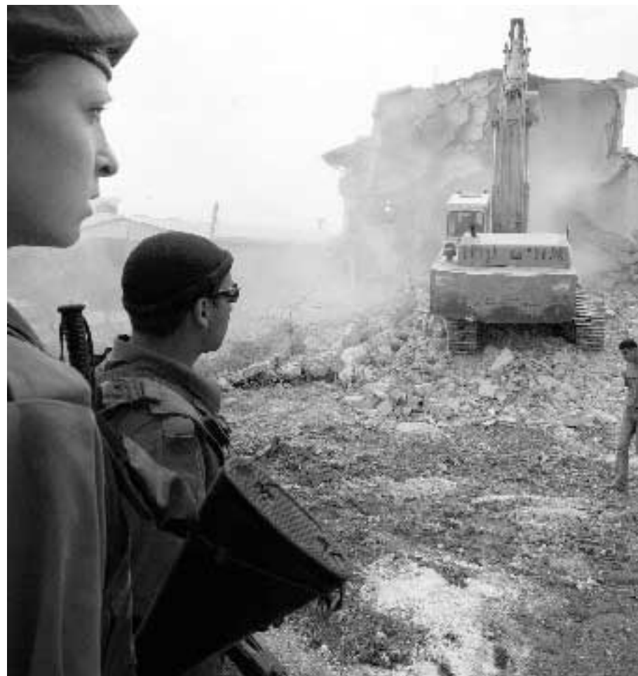
Soldati israeliani controllano le operazioni durante l'abbattimento di una casa a Hebron
