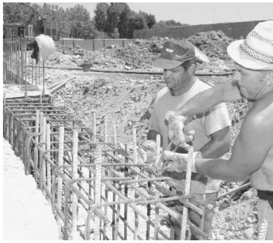
Operai al lavoro in un cantiere edile
