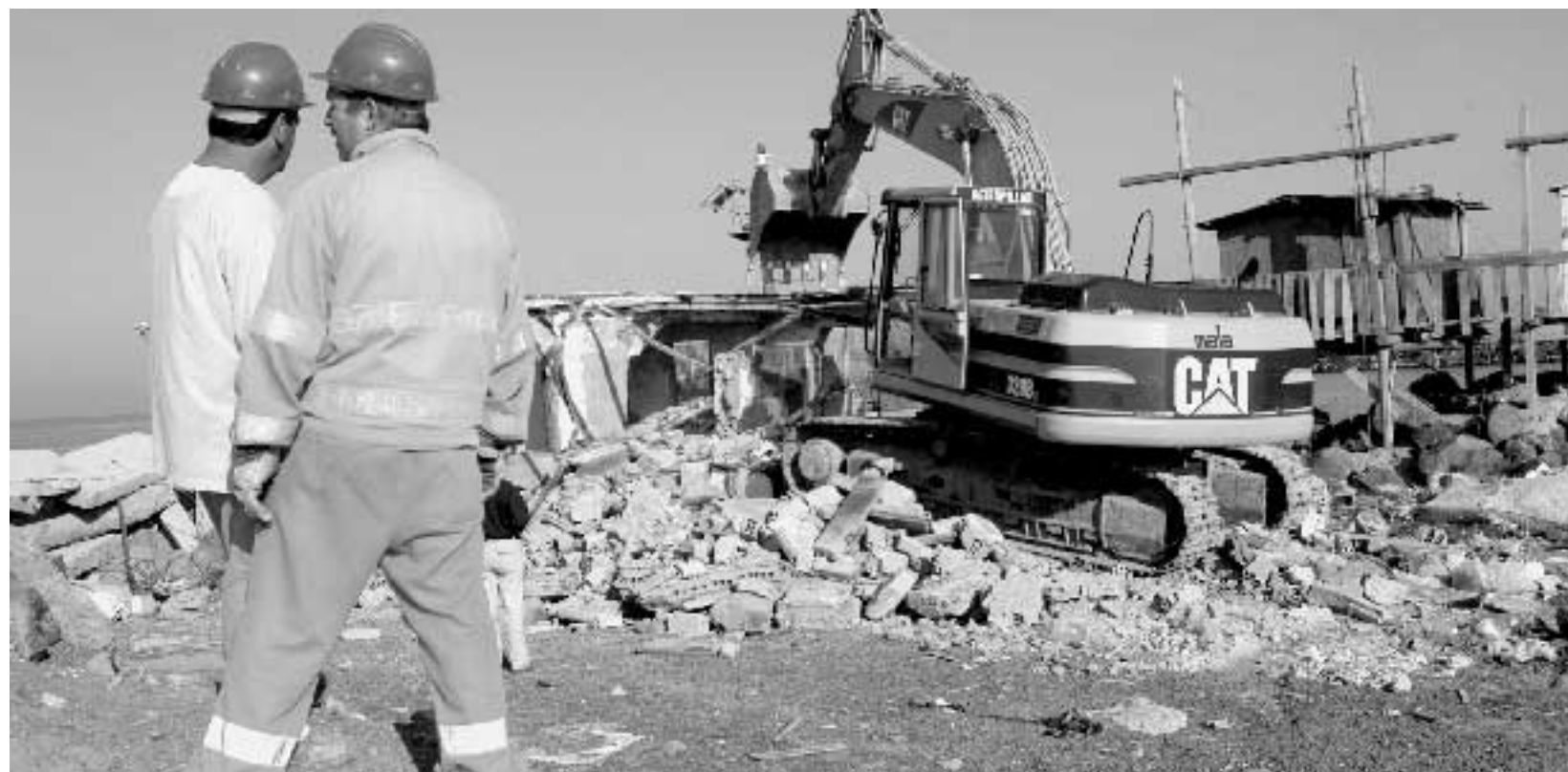
La demolizione di una casa abusiva all'idroscalo di Ostia (Roma) Andrea Sabbadini
