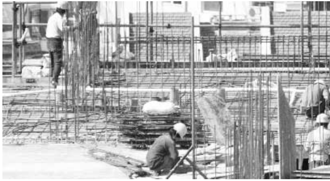
Un cantiere edile
