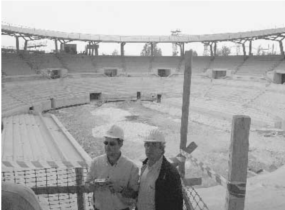
Negli impianti che ospiteranno le gare dei Giochi estivi i lavori continuano a ritmo frenetico
