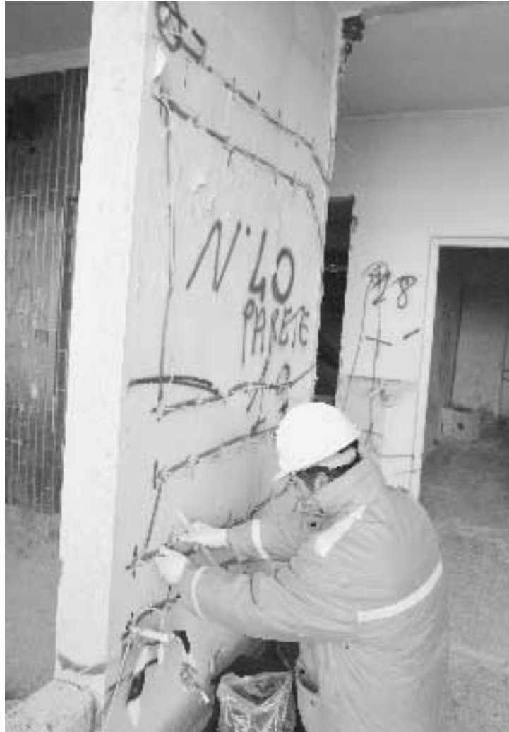
Si preparano le cariche esplosive alle torri di via Artom. Foto Mario Solavagione/MediaMind
