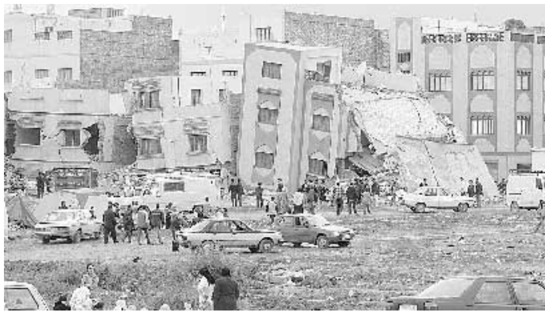
Una palazzina crollata nel villaggio marocchino di Izemuren
