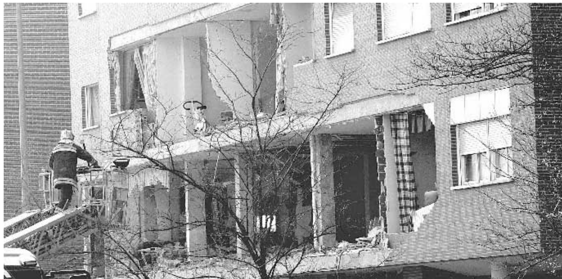
Vigili del fuoco verificano i danni al palazzo squarciato dall'esplosione
