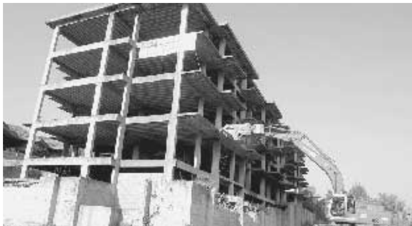
La demolizione dell'ecomostro
